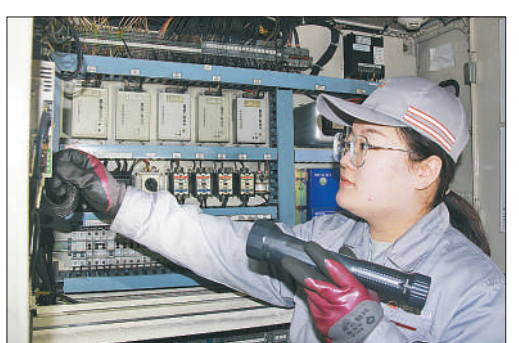
00后青工朱琳在检修电气控制柜。受访者供图
