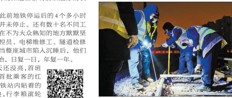
地铁线路维修工正在调整轨道的几何尺寸。
