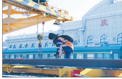
2月19日，庆安火车站，绥化工务段曹工李东正在平板车上处理轨道吊上来的钢轨。 吴健摄
