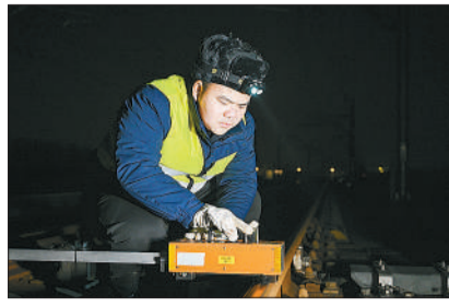
中国铁路西安局集团有限公司西安高铁基础设施段鄂邑综合维修车间汪龙在工作中。 张欣摄
