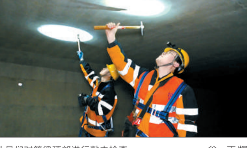
队员们对箱梁顶部进行敲击检查。 谷雨摄
