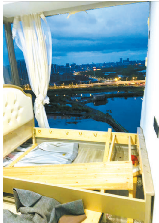
强风过后,张黎家次卧的床垫被吹走,床架也损坏严重。受访者供图
