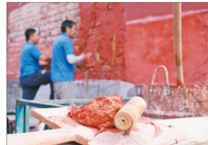
故宫博物院修缮技艺部的宫墙抹灰试验区，学员们正在练习。
