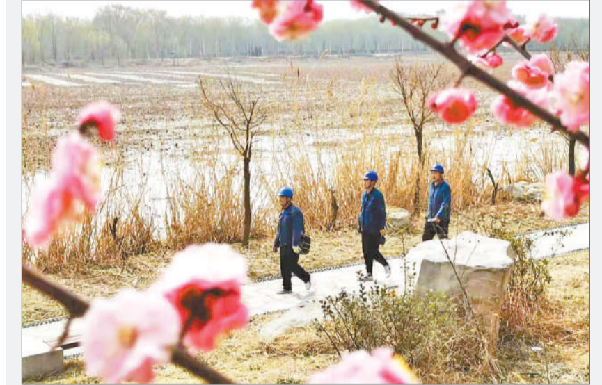
3月16日，国网山东博兴县供电公司湖滨供电所青年团员巡视湖滨镇10千伏滨西线湖区支线，全力保障农民春耕春灌用电需求。 王雪摄影报道
