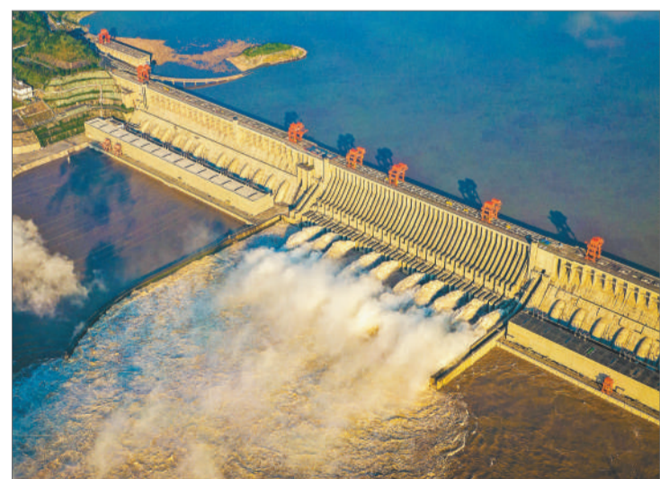
长江三峡水利枢纽工程开启泄洪深孔泄洪(2020年8月19日摄,无人机照片)。三峡工程是迄今为止世界上规模最大的水利枢纽工程和综合效益最广泛的水电工程。
