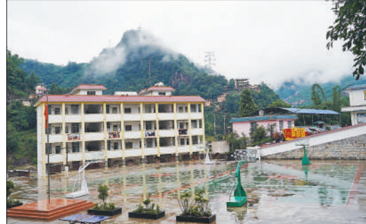
一所学校沿着山势阶梯形建设。
