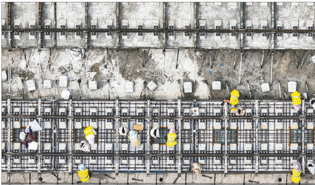
7月13日，浙江湖州现高温天气，沪苏湖铁路南浔段错峰施工。
