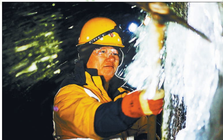
王宏志在清除铁路隧道内积雪。王强摄
