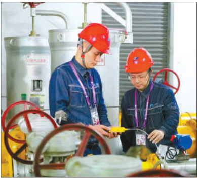
运行人员在燃气计量间检查燃气泄漏情况
